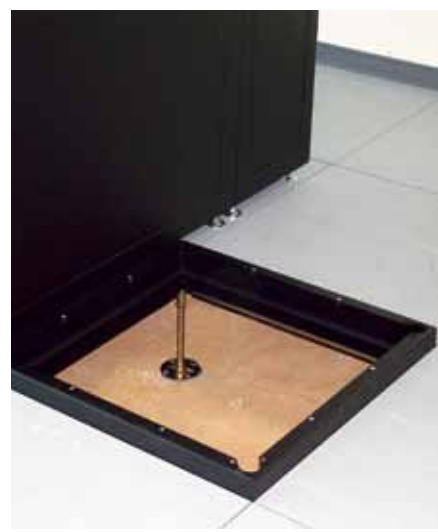
Usazovací podstavec nahrazuje podlahovou dlaždicí a umožňuje umístění rozvaděče na rám dvojitě podlahy
