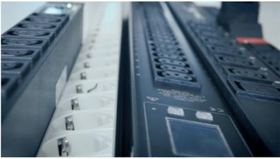
► Notre portfolio de **bandeaux de distribution d'énergie (PDUs)** pour les environnements IT à haute densité comprend 3 types — les **PDUs managés**, permettant à l'utilisateur de contrôler des prises individuellement ou des groupes de prises à distance via un réseau de données, des **PDUs monitorés** permettant une supervision à distance du courant et de la consommation d'énergie du PDU et des **PDUs basiques** sans fonctionnalités supplémentaires.
