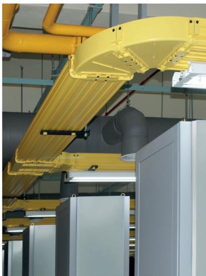
➤ **OptiWay** est conçu pour fournir un système de gestion sûr, facile à utiliser et économique pour les câbles optiques fragiles. OptiWay vous permet d'acheminer les câbles optiques entre les équipements, en assurant à la fois la protection physique et la gestion du rayon de courbure, indispensables aux performances des câbles optiques.
